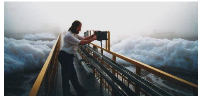
Lafu-Geschäftsführer Gary Zörner nimmt ein Klärwerk in Rostow am Don / Russland in Betrieb
